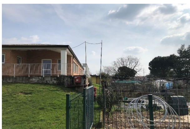
Vista verso Est
